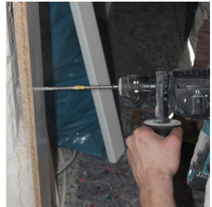
**3.** Die bestehende Seitenverkleidung der Zarge wird mit Schrauben fixiert. Das gibt der schweren Türfüllung Halt und sorgt für zusätzlichen Einbruchschutz.
