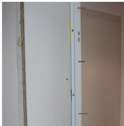
**8.** Für zusätzlichen Schutz wird die Zarge verschraubt. Da wackelt garantiert nichts mehr.
