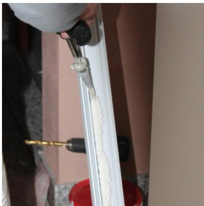
**7.** Die neue Zarge wird mit Spezialschaum vollflächig verklebt. Einbrecher haben keinen Angriffspunkt mehr, um die Tür aufzuhebeln.
