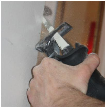
**1.** Mit präzisen Schnitten wird der Rahmen der Tür demontiert. In den meisten Fällen kann mit einer Ummantelungszarge gearbeitet werden, so dass dieser Schritt sogar entfällt. Die seitliche Verblendung der Zarge bleibt erhalten.
