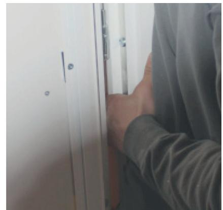
**9.** Die Türfüllung wird eingehängt und die Funktion geprüft. Die WEKU-Monteur stellen Ihre neue Sicherheitstür so ein, dass sie perfekt öffnet und schließt.
