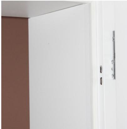
**10.** Für einen sauberen Abschluss werden Verblendungen an der Zarge montiert. Auch diese werden vollflächig verklebt.
