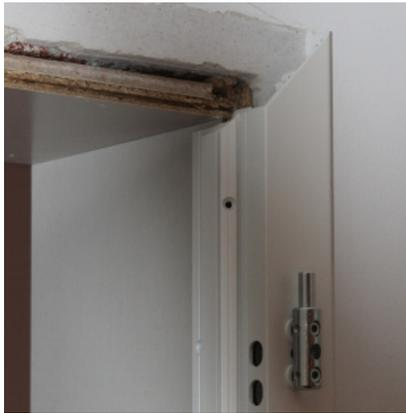
**4.** Der neue Rahmen wird über der alten Zarge platziert. Die verschraubten Sicherheitsbänder bieten hervorragenden Schutz vor Aushebelversuchen.
